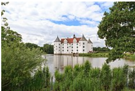
Ansicht von Osten
